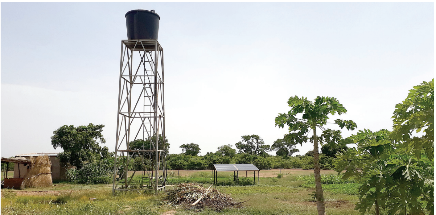
Un parc de technologie solaire installé pour démontrer le potentiel des cultures dans le village de N'Golonianasso, au Mali (photo: Amadou Sidibé).
